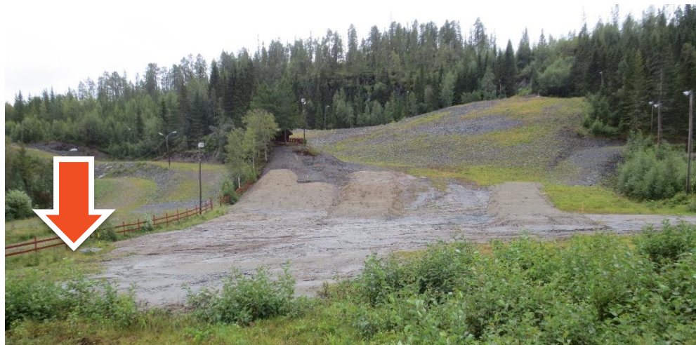
Figur 4. Pilen indikerer punktet lengst oppstrøms hvor det er observert vann og utfellinger
