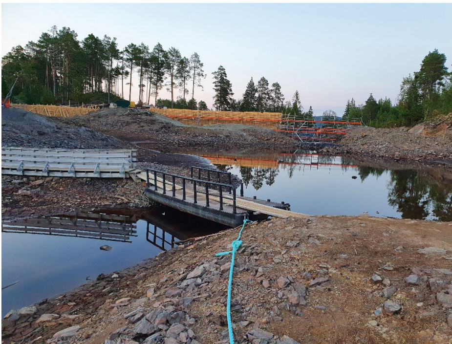
Figur 16: Stavsjøen ved utløp. Vedlikehold av demning sperret atkomst langs den opprinnelige turstien. En midlertidig gangbro for atkomst langs turstien ble lagt over det nederste nedtappede bassenget. Foto: Helge Bardal, Veterinærinstituttet.
