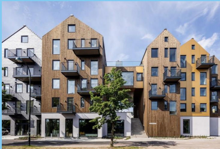
Figur: Viser arkitektonisk uttrykk mot Havnegata i Tønsberg
