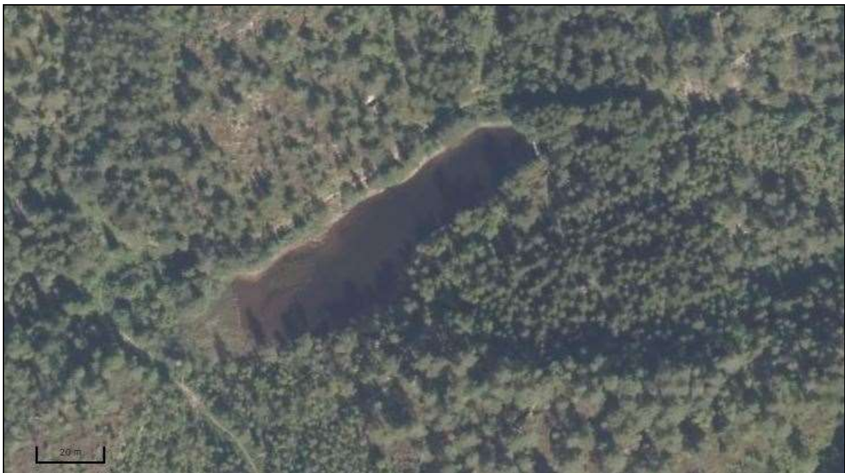
Figur 223. Flyfoto av Svartdalsdammen.
