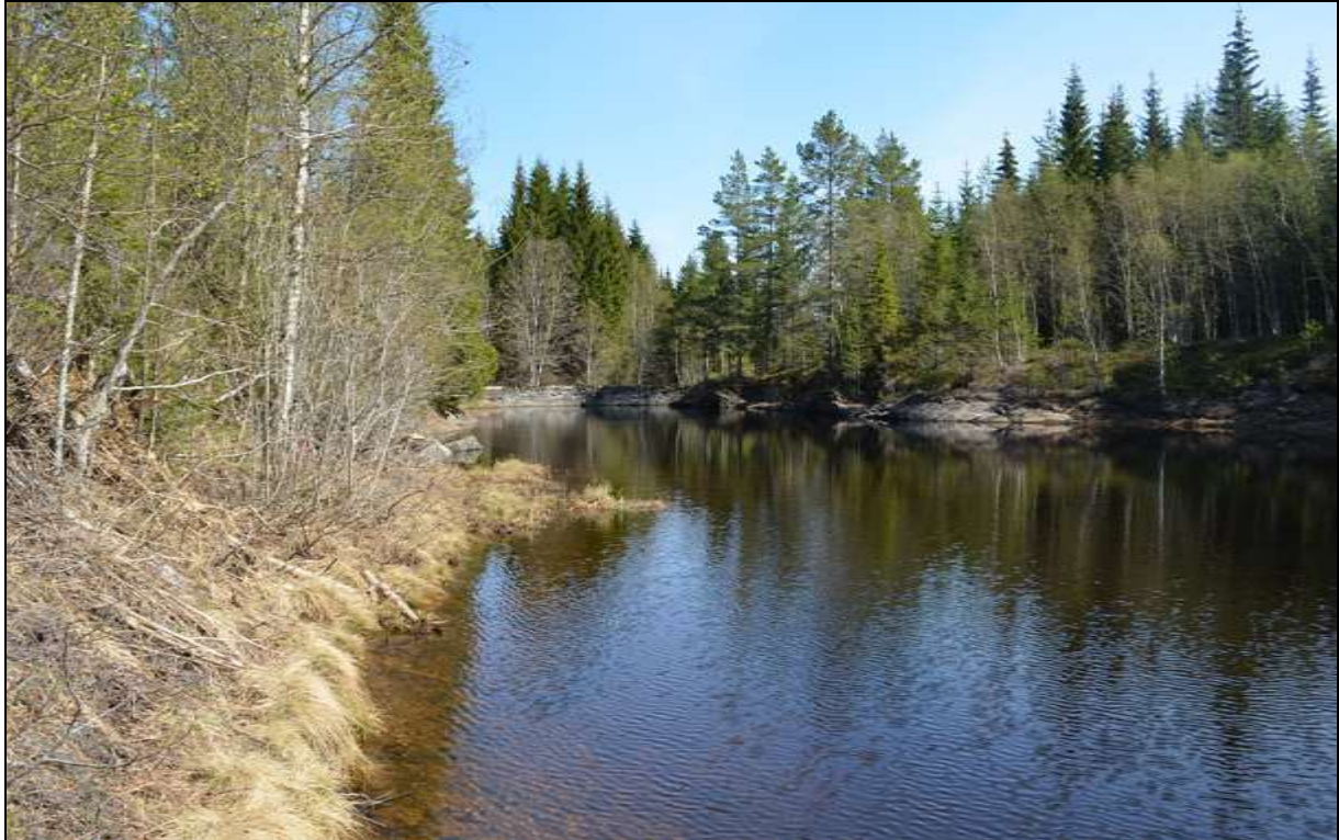
Figur 224. Svartdalsdammen sett fra vest, 7. mai 2016.
