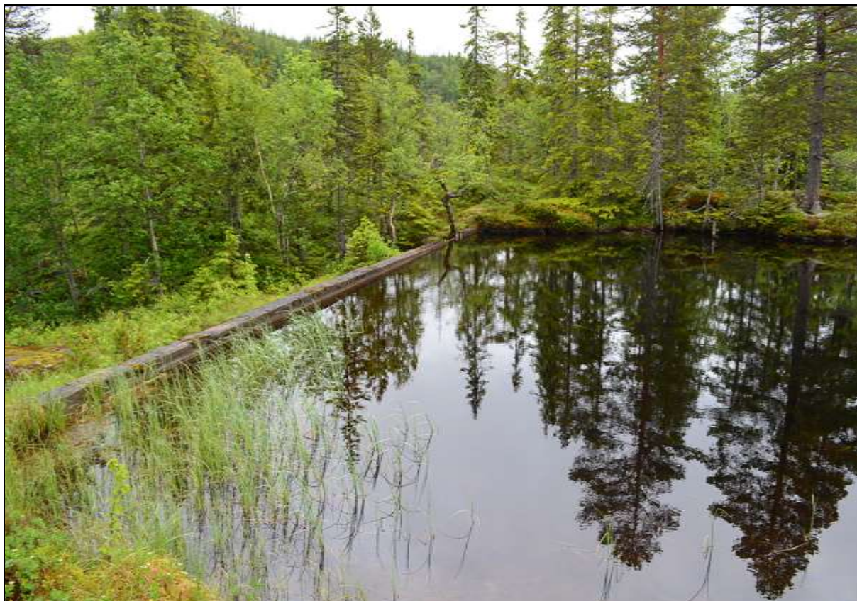
Figur 24. Demning i nordenden av Damtjønna, 21. juni 2016.
