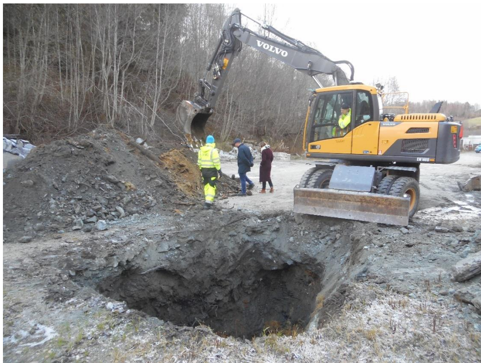
Figur 10 Sjaktning ved Nesset.
