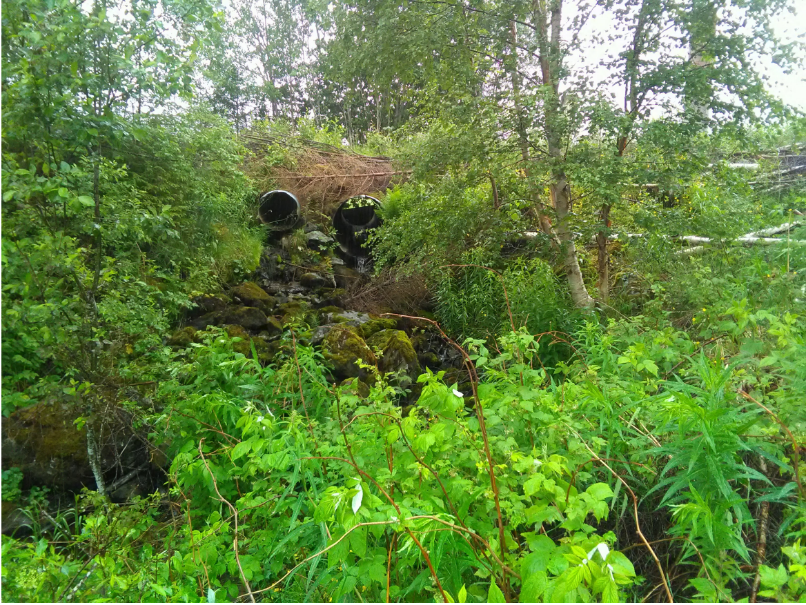
Figur 9. Kulvert mellom øvre og nedre dam ved Bonaunet.
