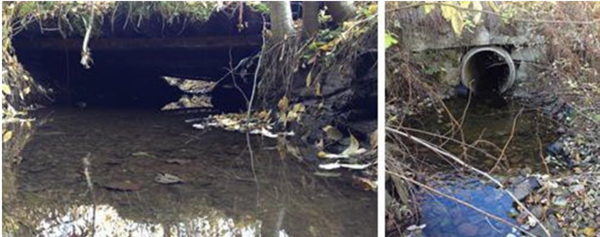
Figur 45. Kulverter under veier som krysser Brøttensmøbekken, hhv. under traktorvei (t.v.) og under Fv 926 (t.h.).
