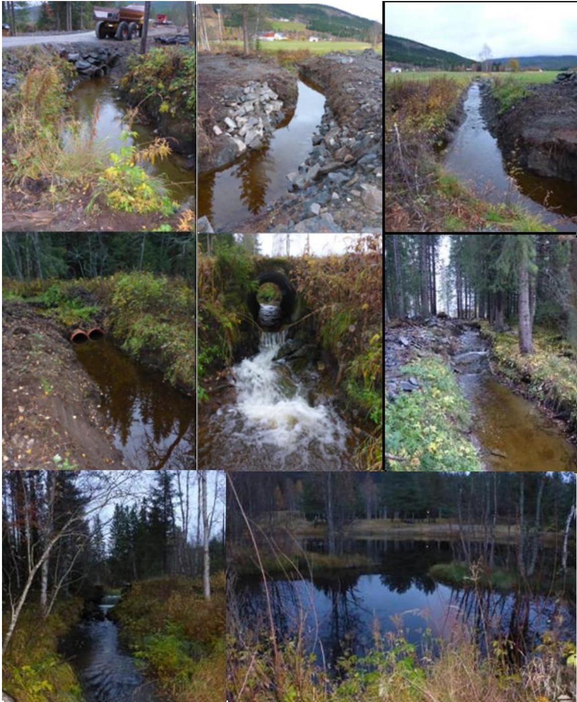
Figur 26. Foto tatt under befaringen i 2013. Nederst: Krokbecken nedre del. I midten den midtre delen som var kanalisert og senket. Øverst: Kanalisert og senket del.
