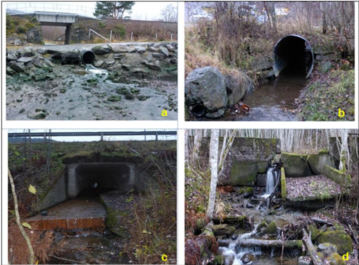
Figur 53. Ulike kulverter og vandringshindre for fisk i Langbekken.
