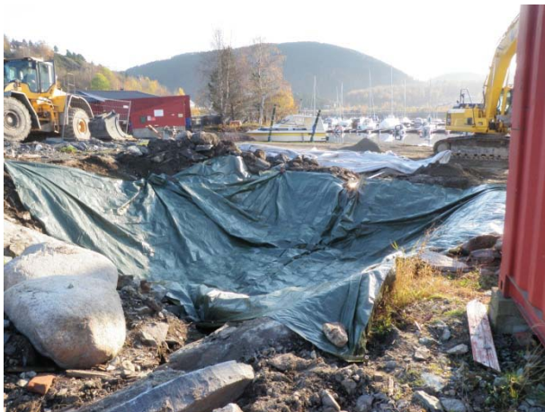
Etablering sedimentasjonsbasseng.
