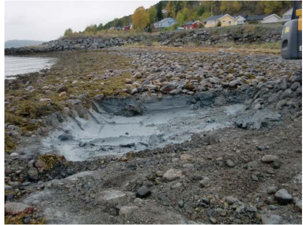
Oppstart i fjæra (nord).
