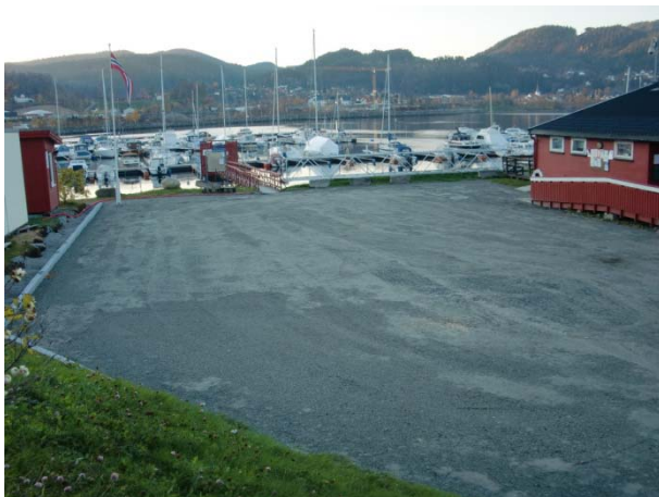
Båthuset – klart til asfaltering.
