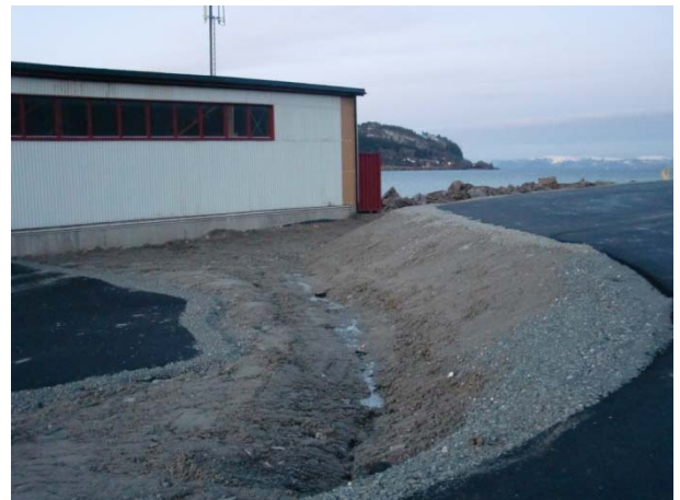
Drensrøft nedkant båtoppstillingsplass.
