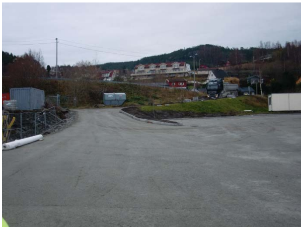
Båthuset – ferdig asfaltert.
