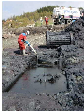
Pumping, fri fase kreosot.
