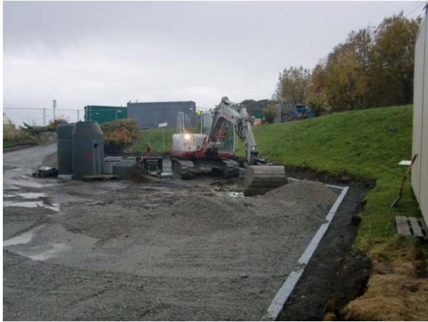
Opparbeidelse rundt båthuset.
