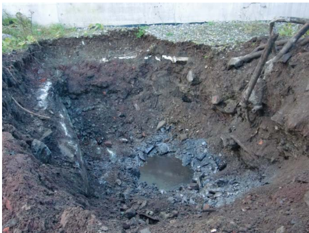
Utgraving nordside båthall.
