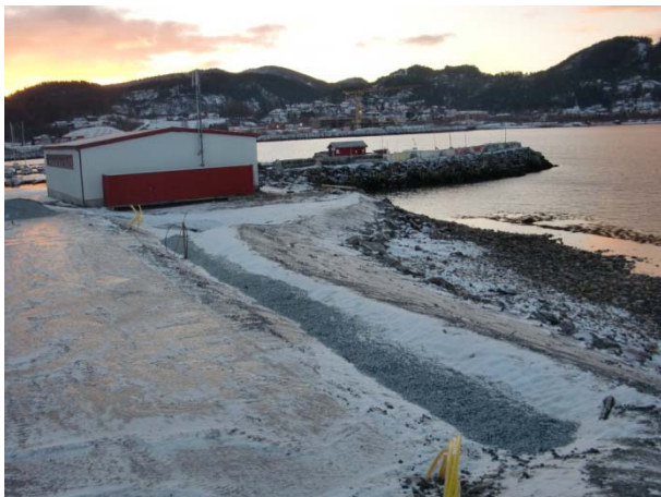
Drensrøft nedkant båtoppstillingsplass.
