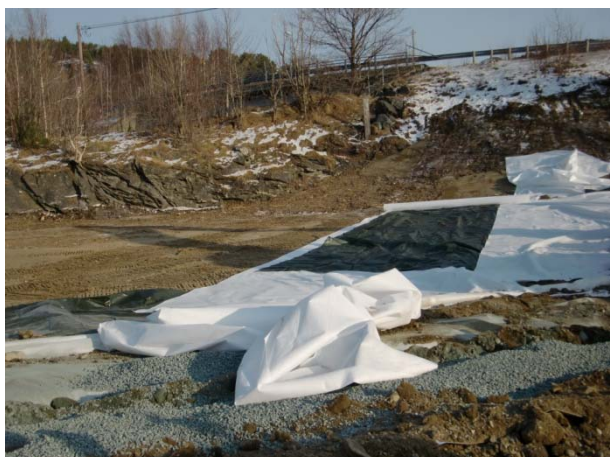
Etablering av mellomlager.
