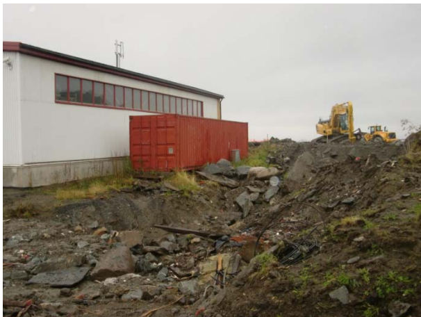
Østside av båthallen.
