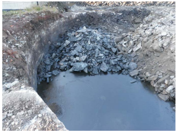
Kreosottank – masser inni (fjernet).
