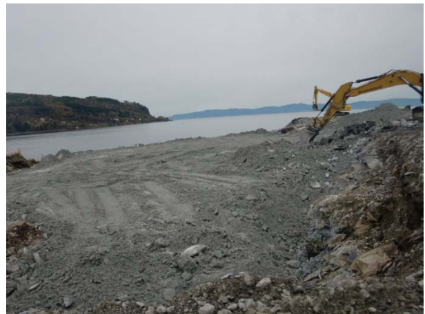
Opparbeidelse båtoppstillingsplass med bunnrensk.
