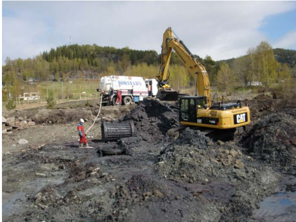
Pumping av fri fase kreosot.
