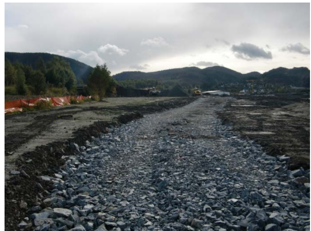
Opparbeidelse veg til renseanlegg.
