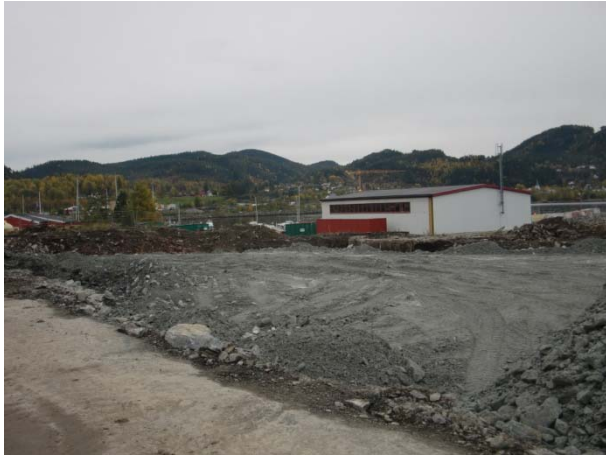
Opparbeidelse båtoppstillingsplass med bunnrensk.
